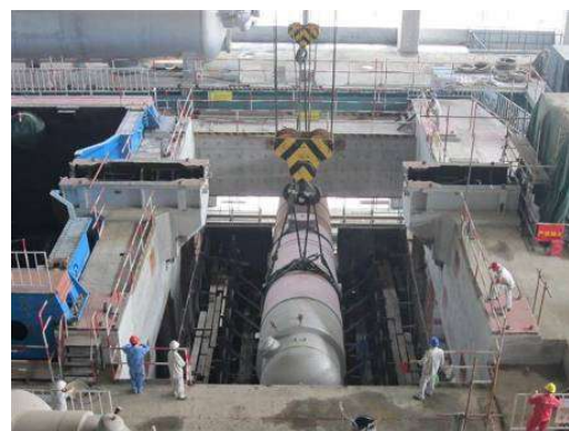
图 12 双联低压加热器就位
