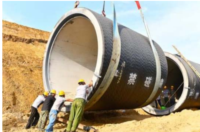
图11 吊机吊运循环水管就位
