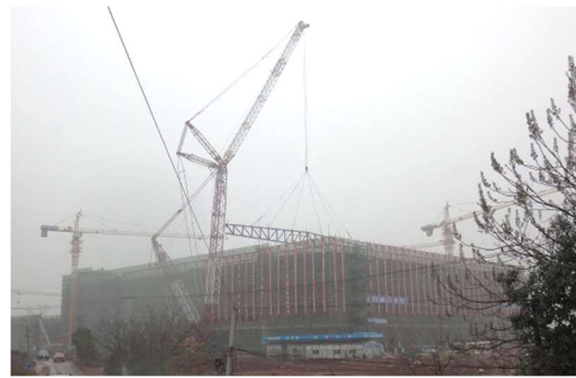
图（10）钢桁架现场吊装图
