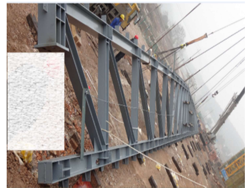
图（5）钢桁架翻边示意图
