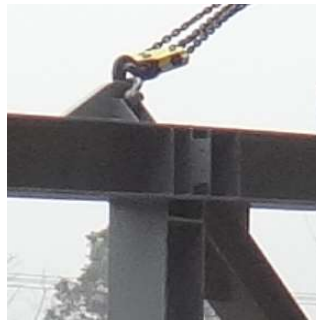
图（7）吊点处吊耳制作图
