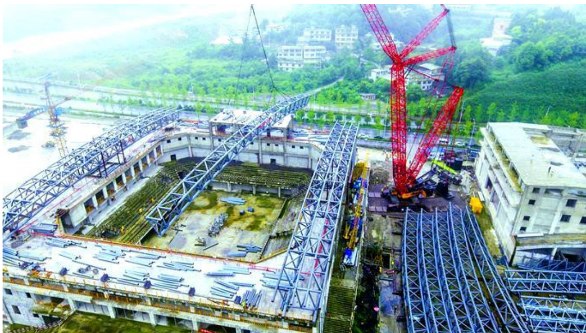
图 11 750t 履带吊吊装全景
