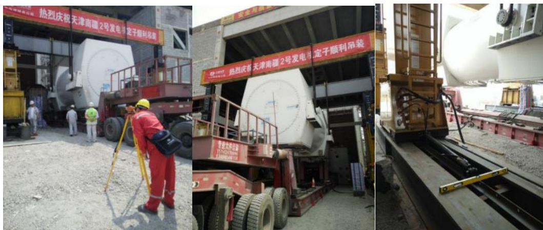
图 19：试吊，检测地基沉降 图 20：正式起吊 图 21：向基础位移
