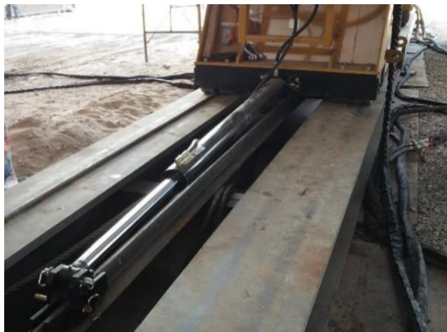
图 6：液压顶升装置牵引行走油缸
