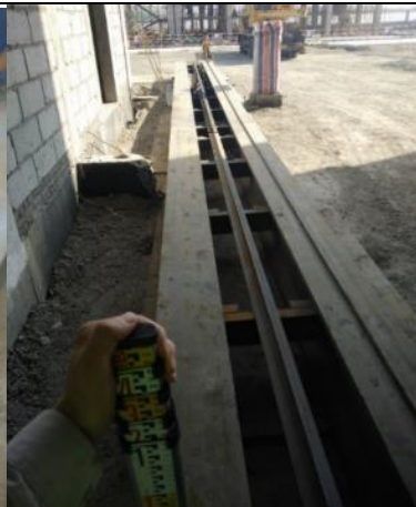
图 14：滑移轨道找平、找正
