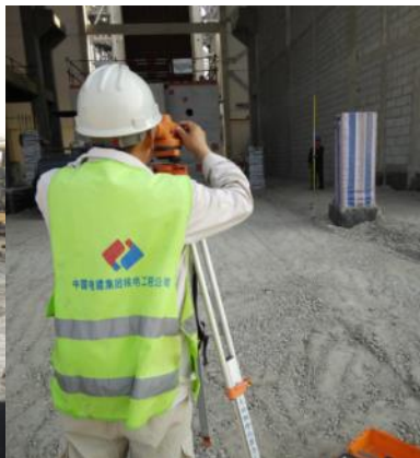
图 12：滑移轨道铺设区域地面测平
