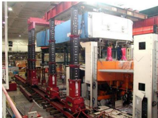
图 2：液压顶升装置进行设备吊装
