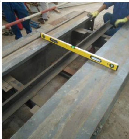
图 13：滑移轨道铺设
