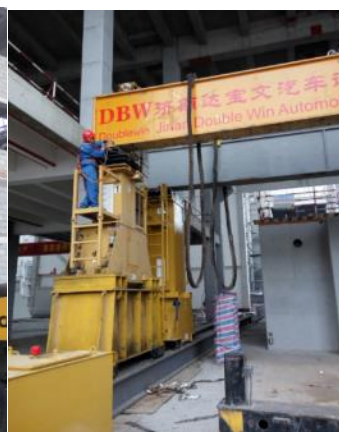
图 16：安装横梁压板及螺栓
