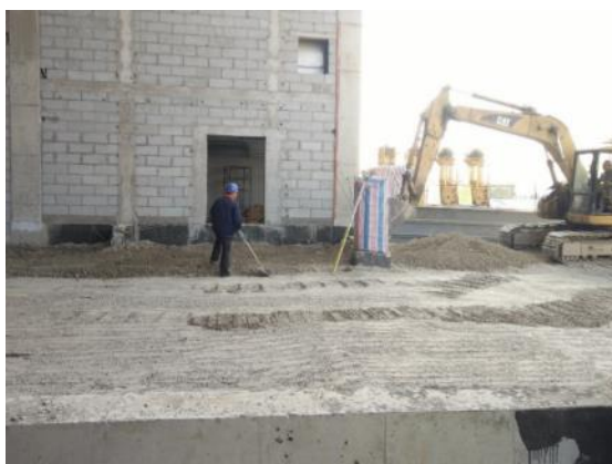
图 11：吊装区域地基回填
