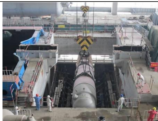
图 12 双联低压加热器就位
